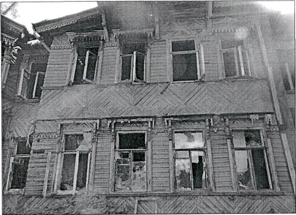
8. "Загородный дом Л.А. Змигородского". Западный фасад. Фрагмент.
