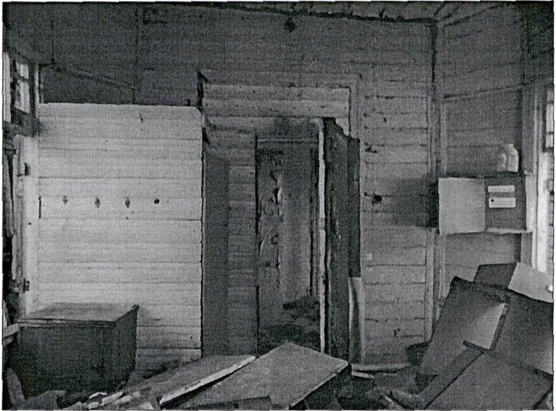
9. Северо-западная веранда в уровне первого этажа.
